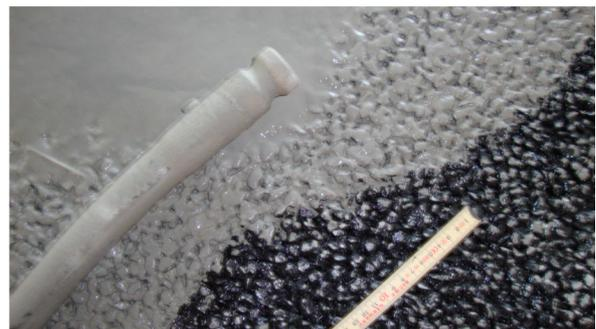
**Abb. 30** - Seehoftunnel: halbstarre Belag – aufbringen des hochviskosen zementgebundenen Fließmörtels
