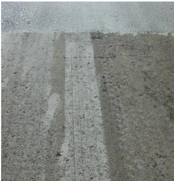
**Abb. 40** - Reifenspur und Zementspritzer in Richtung Meran
