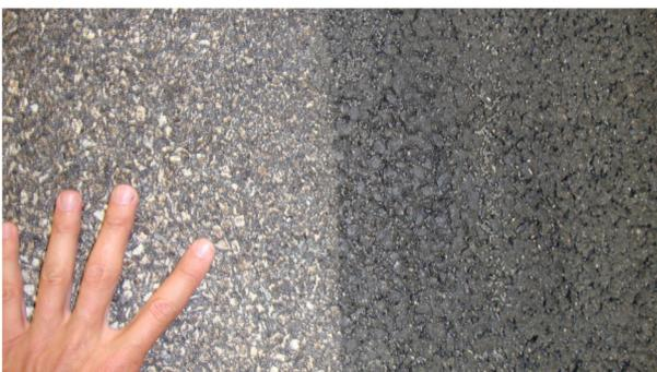
**Abb. 31** - Seehoftunnel: Decke mit Aufhellungsgestein, künstliche Alterung (gestrahlt) und naturbelassen.
