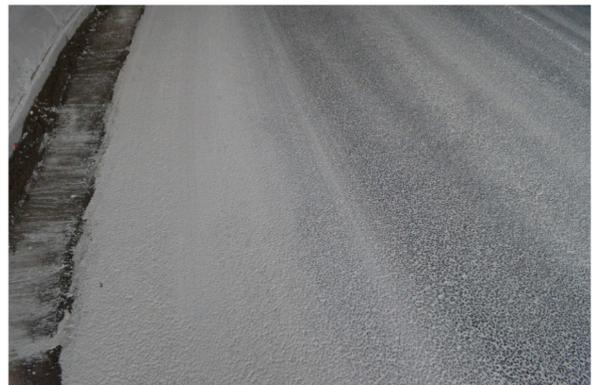
Abb. 20 - Der oberflächliche Mörtel wurde durch die Autoreifen abgetragen
