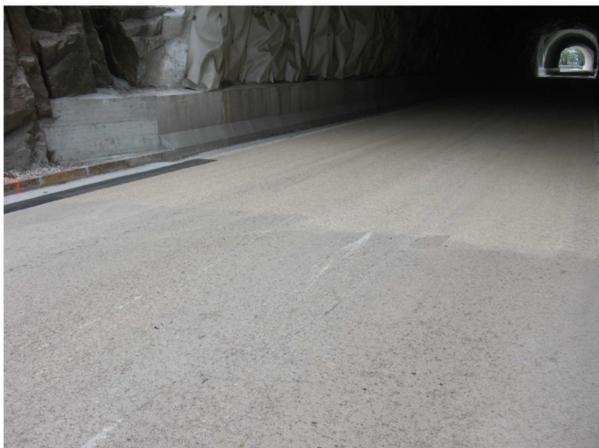
**Abb. 21** - Straßenbelag mit durchsichtigen Bitumen – Im Vordergrund der nicht kugelgestrahlte Bereich
