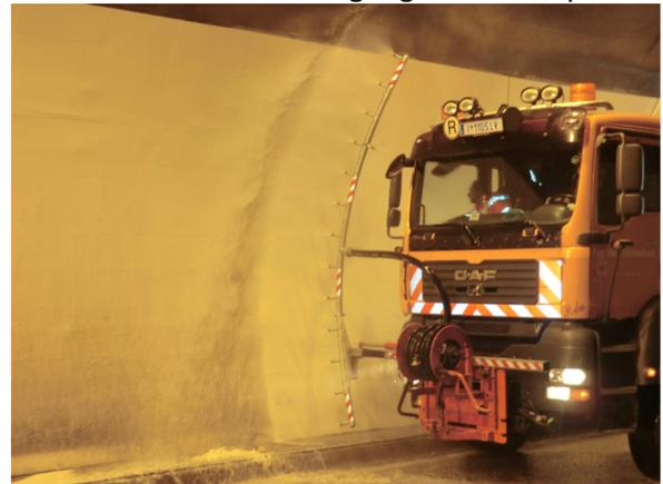
**Abb. 45** - Tunnel Rattenberg - Reinigung der Ulmenfläche
