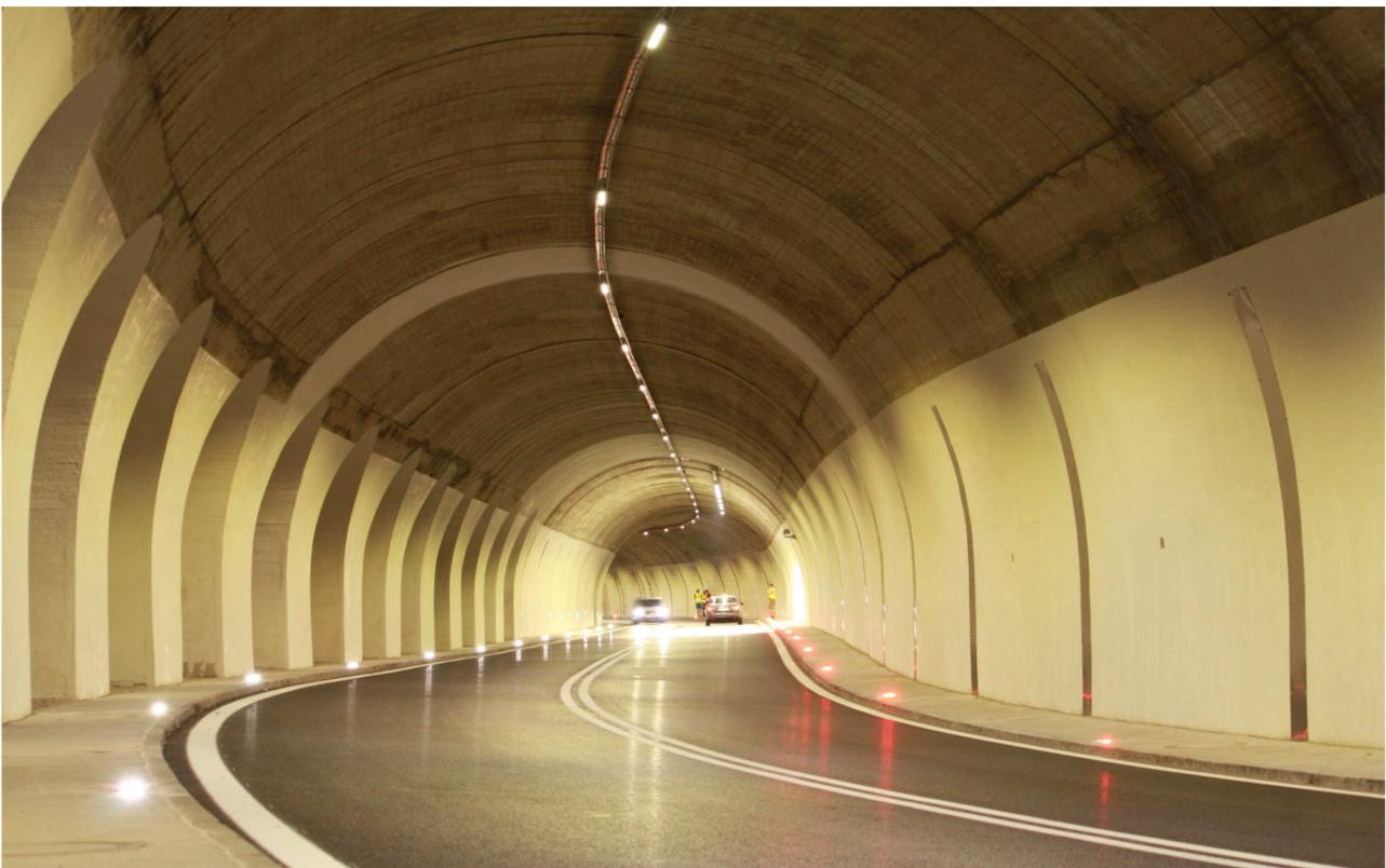
**Abb. 33 - Seehoftunnel: LED Einfahrts - und Durchfahrtsbeleuchtung sowie Leiteinrichtung am erhöhten Seitenstreifen**
