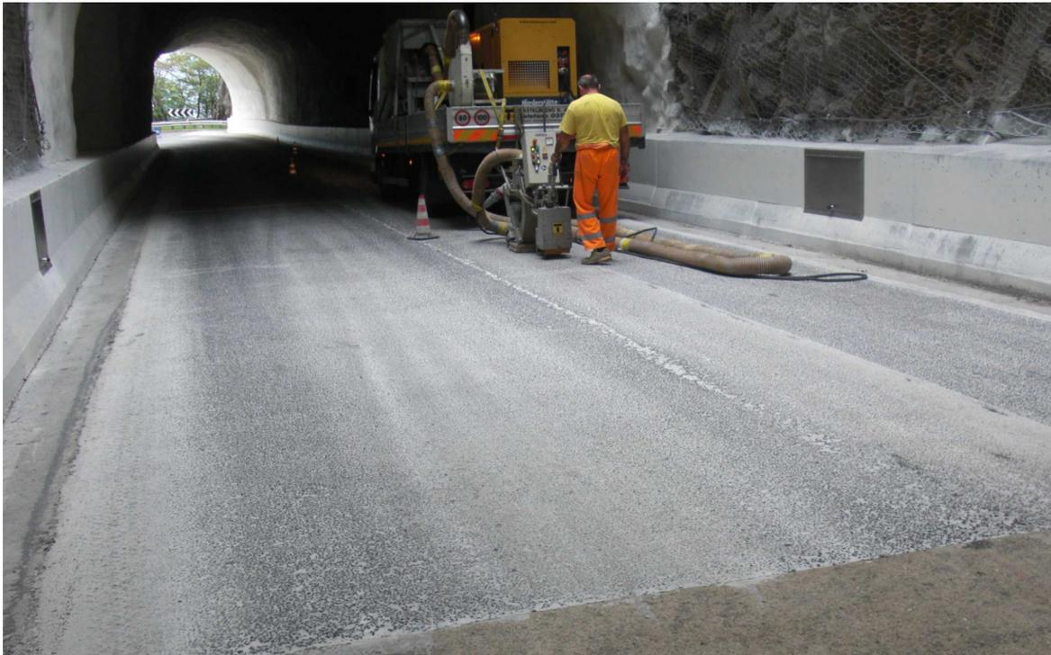
**Abb. 25** - Ausführung des Kugelstrahlens im zweiten Tunnel von Naraun
