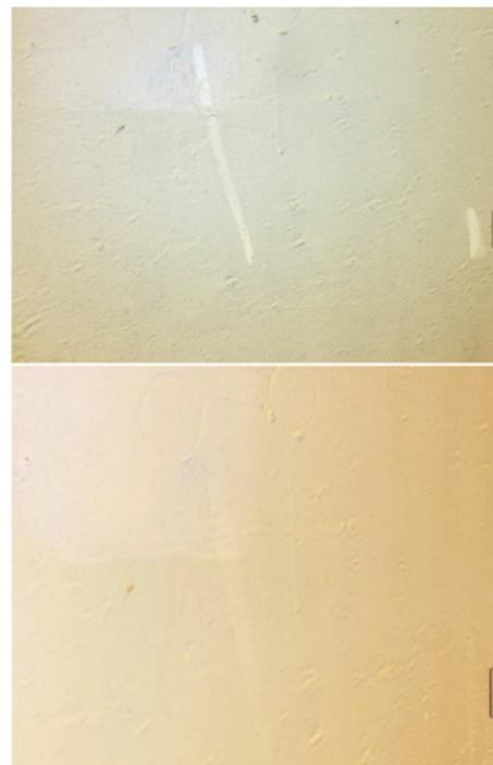
**Abb. 46** - Tunnel Rattenberg - Vor und nach der Waschung
