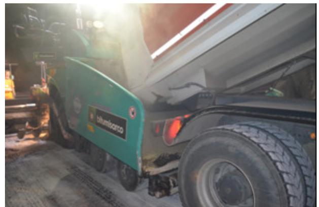
**Abb. 17** - Entladen des Mischgutes in den Straßenfertiger – Tunnel Naraun 1
