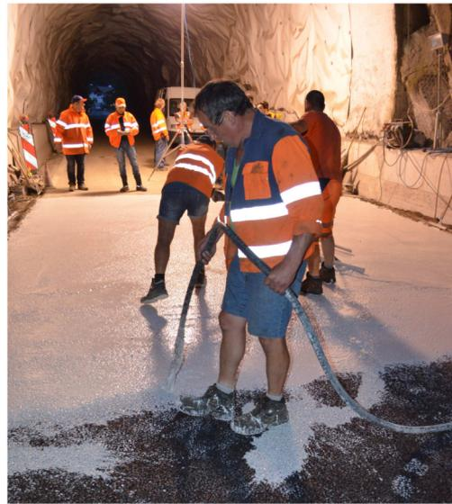
Abb. 19 - Verfüllen des Mörtels
