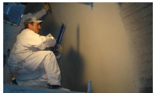
Abb. 29 - Seehoftunnel: Ulmenbeschichtung - aufbringen und abziehen der Spritzspachtel
