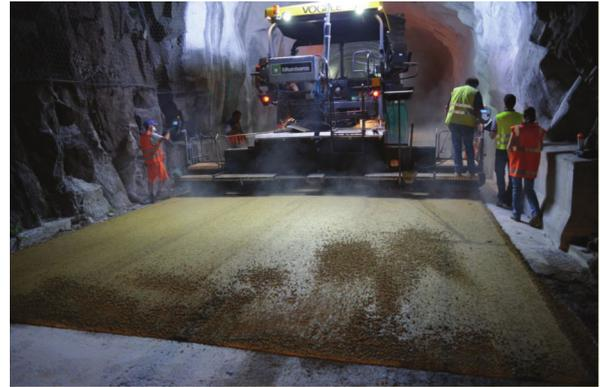
**Abb. 16** - Einbau auf der gesamten Fahrbahnbreite – Tunnel Naraun 1
