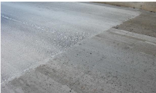
**Abb. 38** - Übergang zwischen den beiden Belagstypen – Man beachte die Verschmutzung durch den Zementmörtel
