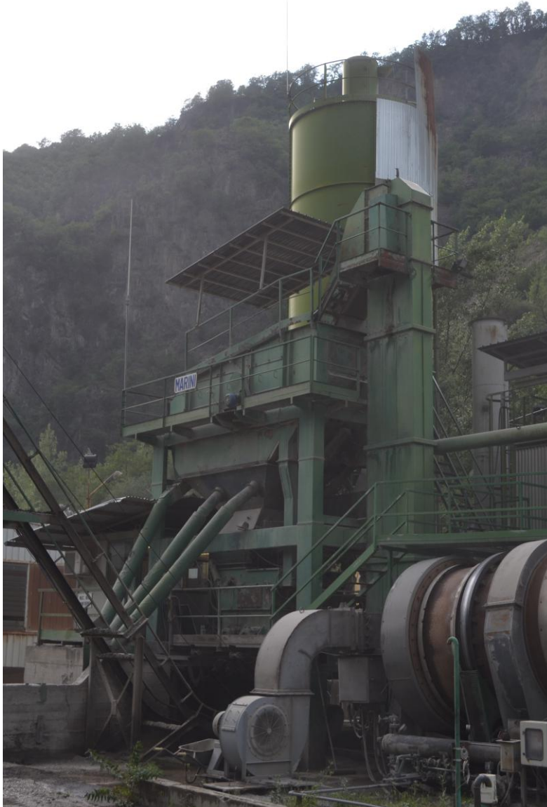
Foto 1 – Impianto Bitumisarco a nord di Bolzano
