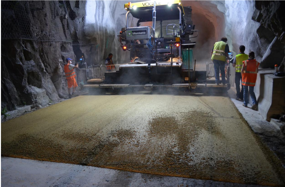
Foto 3 – Stesa a tutta larghezza – Galleria di Tesimo
