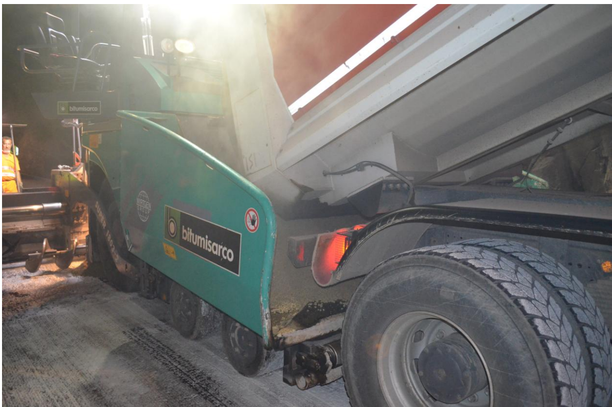
Foto 4 – Scarico della miscela nella tramoggia della finitrice – galleria di Tesimo
