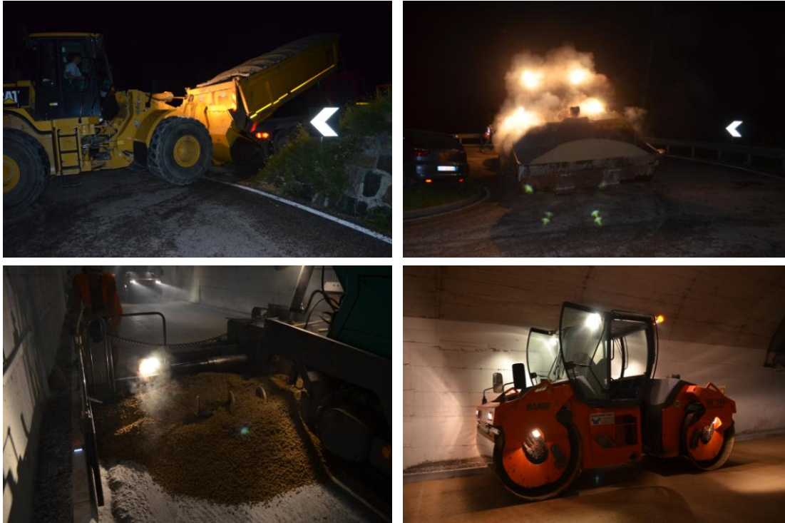
Foto 5 – Stesa e compattazione nella galleria n. 6 di Moso in Passaria
