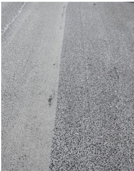
Fig. 26 - Differenza tra prima e dopo il trattamento
