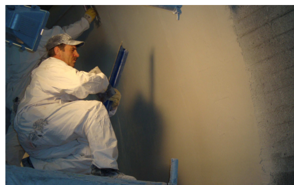
Fig. 29 - Galleria Seehoftunnel: Rivestimento delle pareti – posa in opera della malta cementizia
