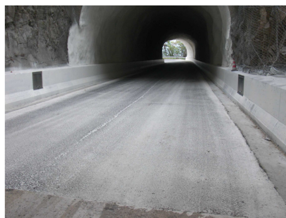
Fig. 24 - Pavimentazione intasata con malta cementizia il 5 settembre 2013
