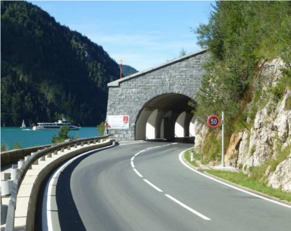
Fig. 32 - Galleria Seehoftunnel: portale sud
