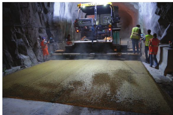
Fig. 16 - Stesa a tutta larghezza – galleria di Narano 1
