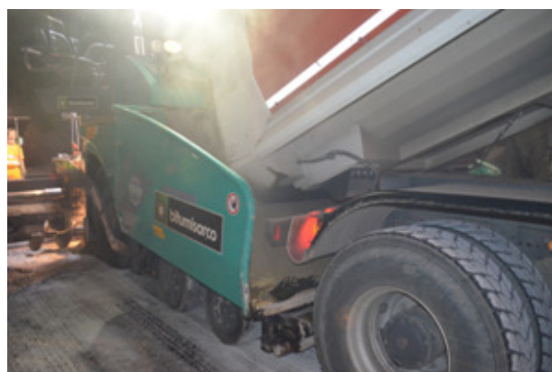
Fig. 17 - Scarico della miscela nella tramoggia della finitrice – galleria di Narano 1
