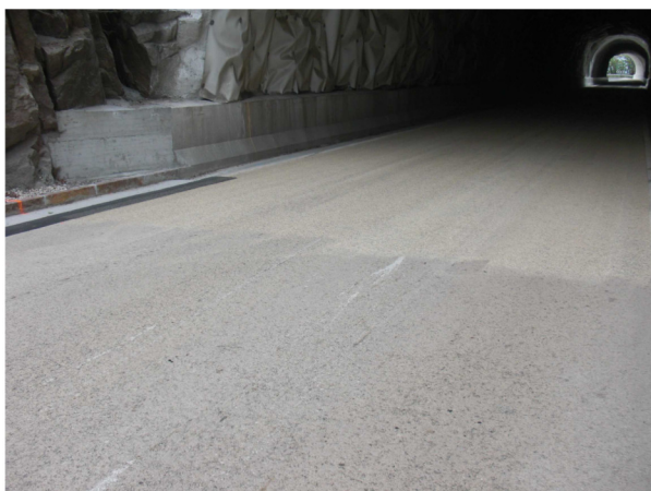
Fig. 21 - Pavimentazione con legante trasparente – In primo piano la zona non trattata
