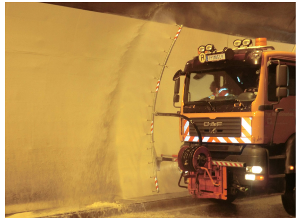
Fig. 45 - Galleria Rattenberg – Pulizia delle pareti
