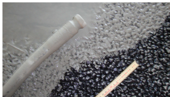
Fig. 30 - Galleria Seehoftunnel: pavimentazione semirigida – posa in opera della malta cementizia fluida ed alta viscosità
