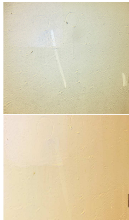
Fig. 46 - Galleria Rattenberg – Prima della pulizia e dopo la pulizia
