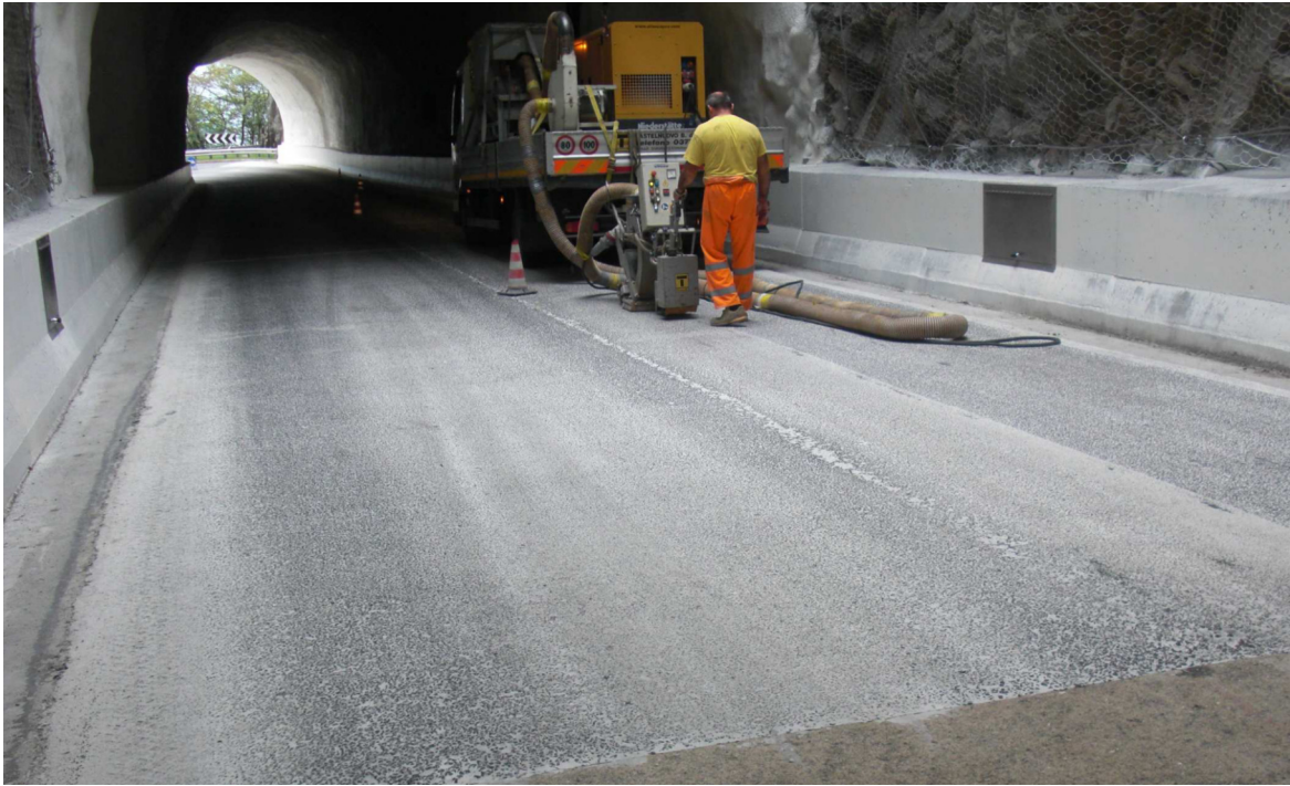
Fig. 25 - Esecuzione della "pallinatura" nella seconda galleria
